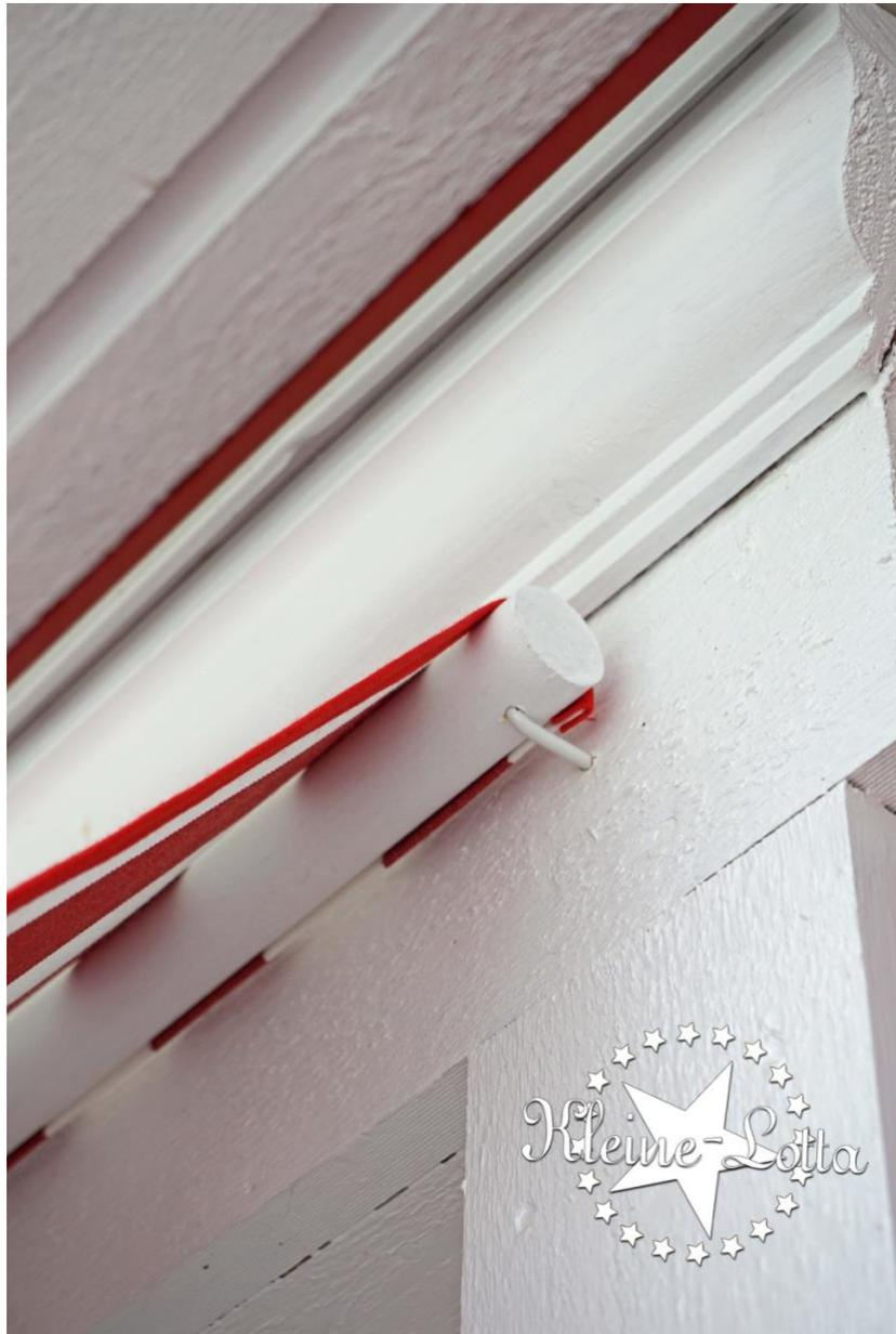
*Rundstab B wird an der Wand nur mit einem Hacken und einer Öse befestigt, so kann die Markise jederzeit einfach wieder abgenommen werden.*
