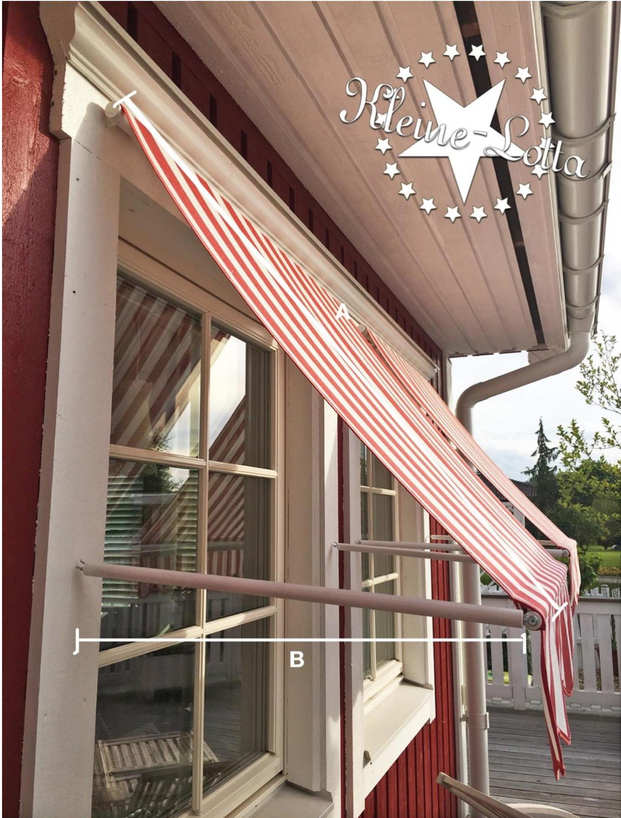
*Die Länge A ist gleichzeitig auch die Länge für den Markisenstoff
