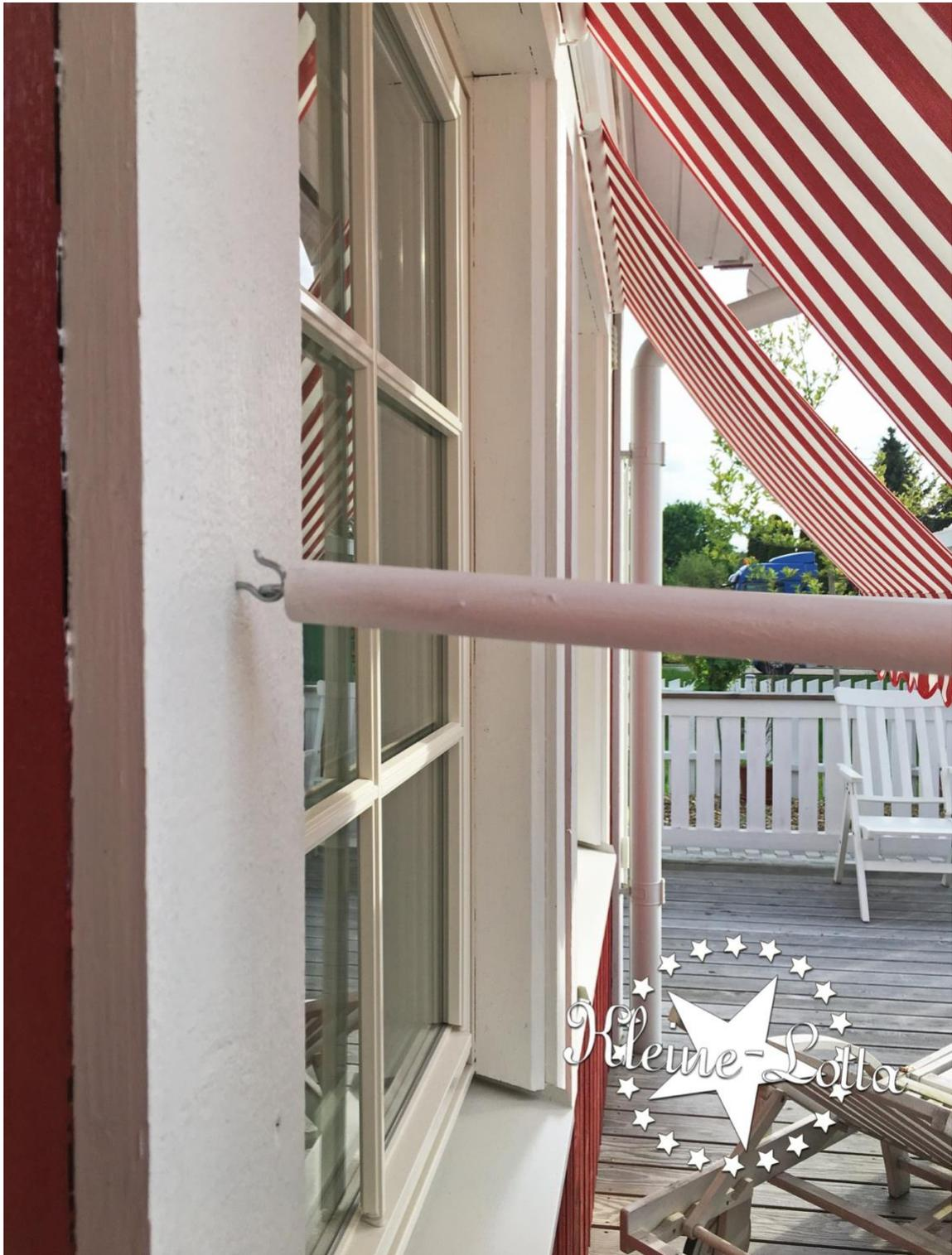
*Rundstab 2 wird an den Rundstäben B mit jeweils einer Öse und einer Schraube befestigt.*
